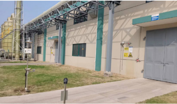
危险固废仓库
